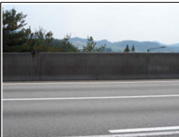
방호벽 전경 (양평)
