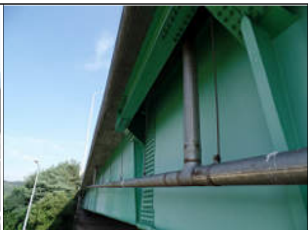
배수시설 전경 (양평)
